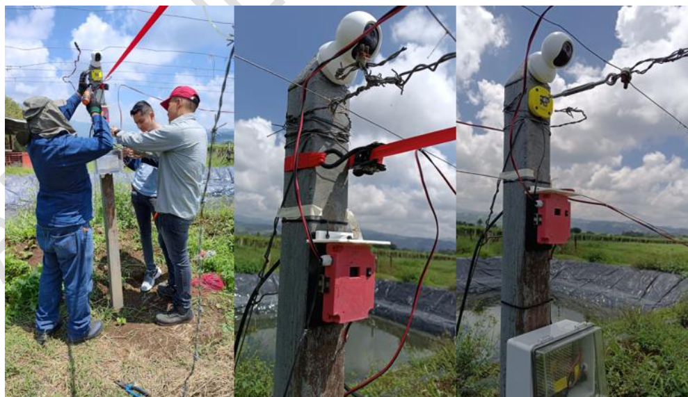
Figura 13. Instalación de los instrumentos para el registro de la información en el tapanco experimental.
